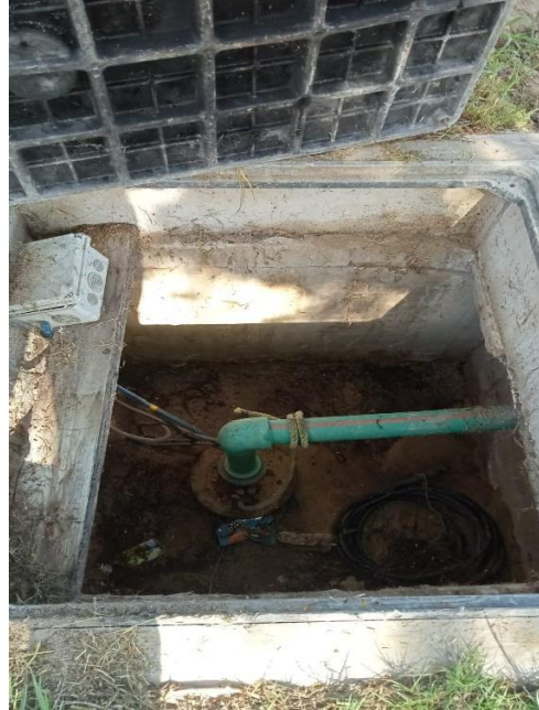
إحدى غرف تفتيش أعلى قيسون به طلمبة أعماق لنزح المياه الجوفية واستخدامها في ري الملاعب وأحواض الزراعة
