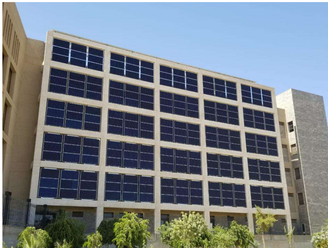
شكل 5 صورة المحطة الشمسية لواجهة مبنى فرع اسوان
